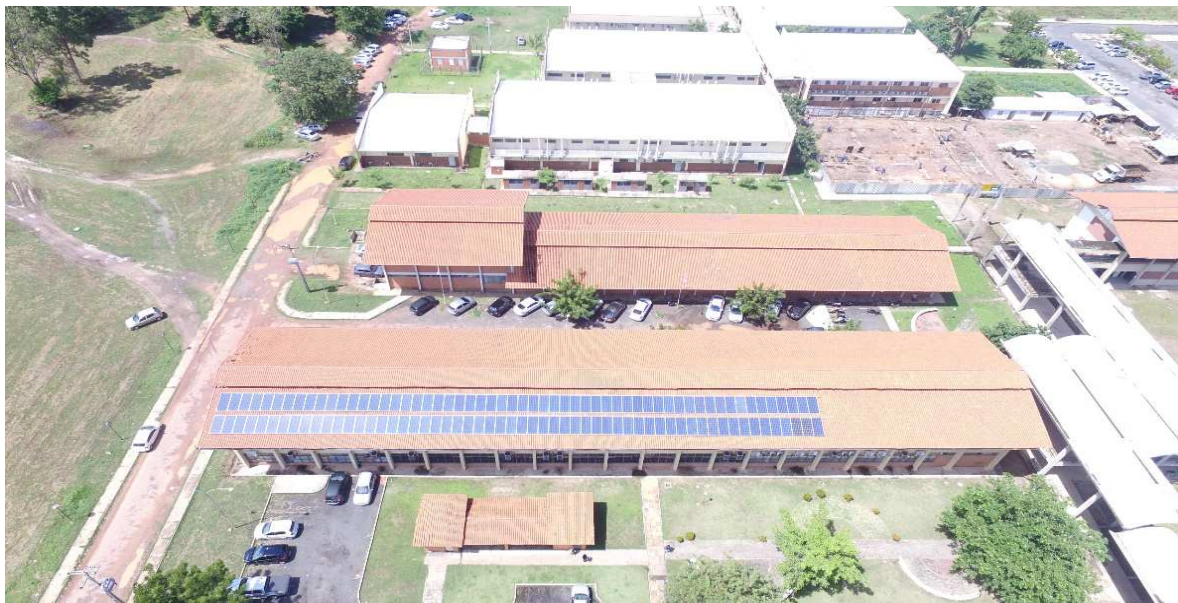
Figura 01 – Imagem aérea do Centro de Tecnologia – UFPI, com as placas fotovoltaicas Fonte: Arquivo Fotos Prof. Marcos Lira/UFPI.
